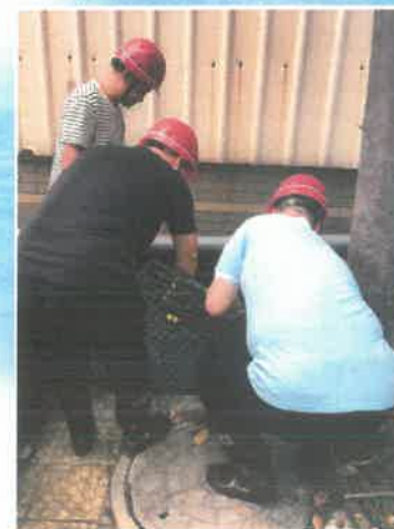
4.打开雨水井盖。
