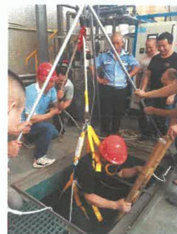
清理过程中蒋学坤突发晕倒，池外监护人员王春林用力拉安全绳把蒋学坤拉上来救出安全区域。
