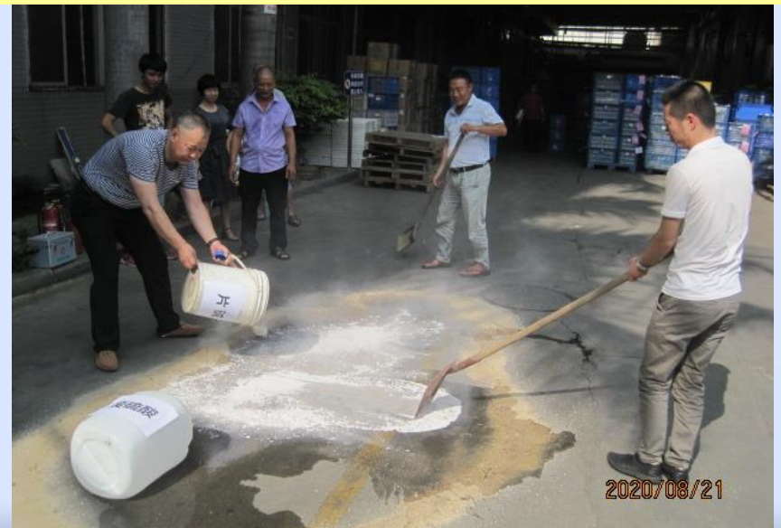
抢险消防组用沙子围堵
